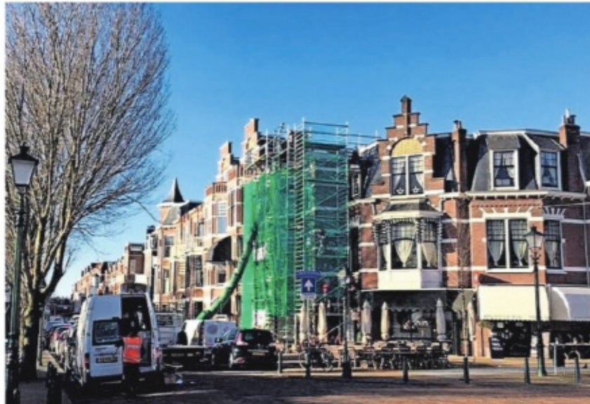
▲ Het pand aan het Frederik Hendrikplein dat volgens de eigenaar met liefde wordt gerenoveerd.
